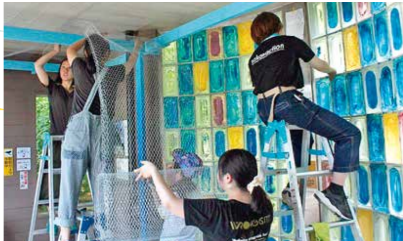
現地での組み立て作業
